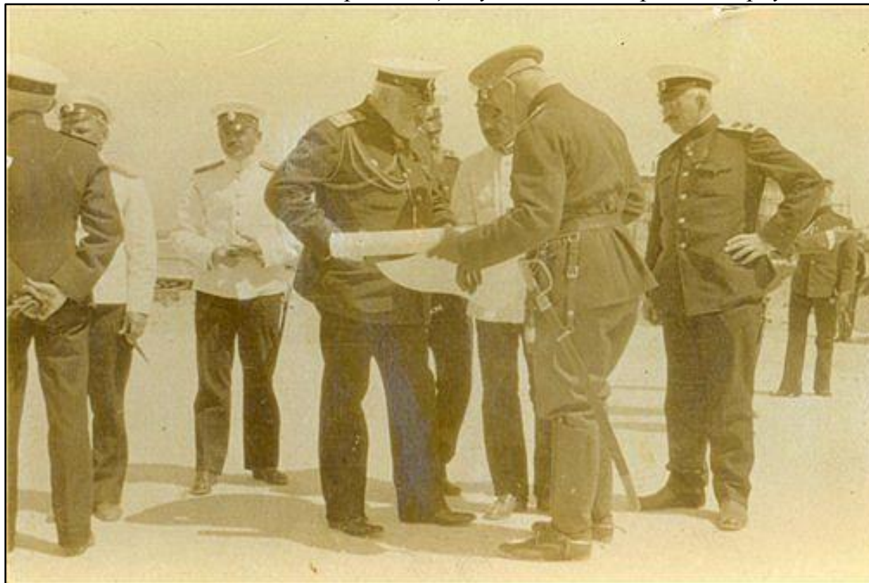
Адмирал И.К. Григорович и В.Ф. Баумгартен осматривают стройплощадку и эскизный проект Корпуса, 1914г.
